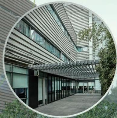
저층부 정면은 투명유리로 마감해 건물 내부에 있는 사람들과 제품들이 건물 내부의 일부처럼 보이게 했으며 동시에 넓은 공간감을 확보했습니다. 상층부는 curtain wall공법을 사용해 가볍고 경쾌한 느낌을 주면서도 세련된 느낌을 주도록 디자인 되었으며 건물의 roof 전체를 유리로 마감해 시원하고 개방된 느낌이 들도록 설계되었습니다. 지하로 통하는 선크데크는 노출 콘크리트로 외벽을 마감해 고급스러운 느낌을 살렸습니다.
